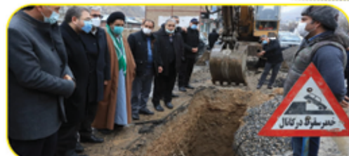
۶ آغاز عملیات اجرایی پروژه فاضلاب شهری ماکو
